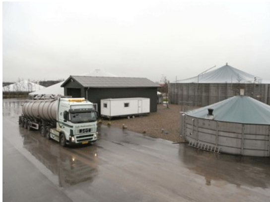
Billede 6: Transport af gylle og afgasset biomasse[1]
